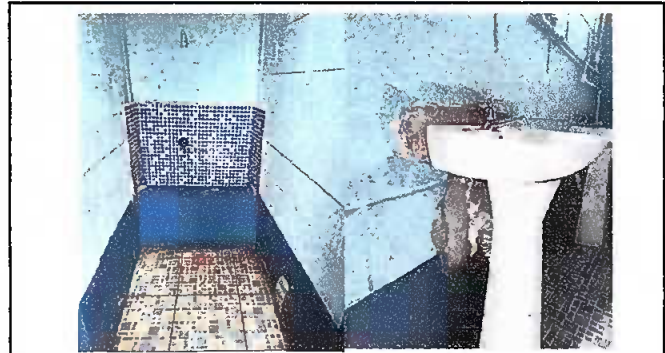
Fotos 4: MODULO 2: Sustitucion de inodoros y sustitucion de lavamanos IN SITU
