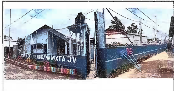
Foto 6: Muro perimetral. Reparación de muro de block .
