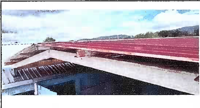
Foto1: Patio: Sustitución de lamina por lamina troquelada aluzinc y sustitución de estructura de soporte de metal por metal
