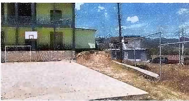
Foto 3: reparación de torta de cemento en patio.
