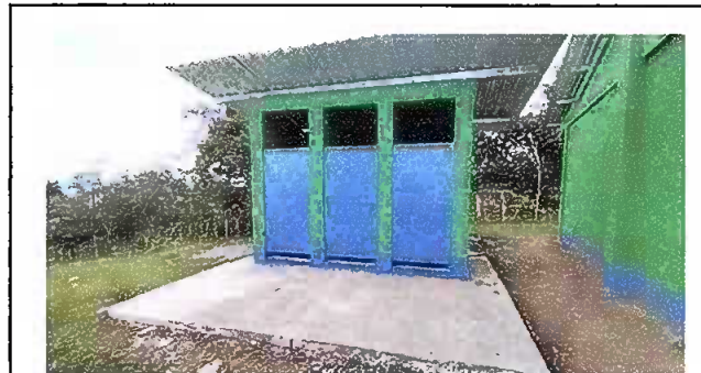
Foto 6: Modulo 2: Puertas de servicio sanitarios instalados.
