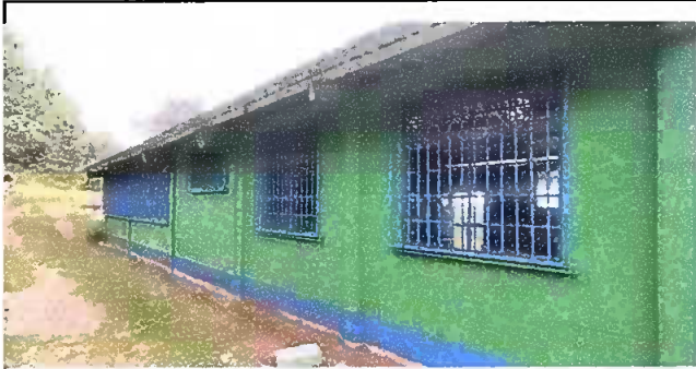
Foto 1: Módulo 1: Balcones instalados
