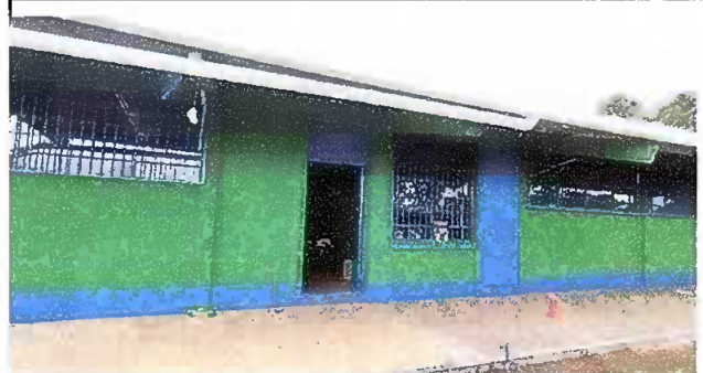
Foto 2: Modulo 1: Piso torta reparado
