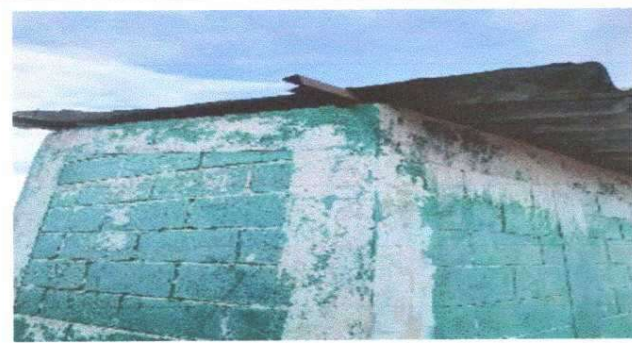
Foto 5. Modulo 2: Sustitución lámina por lamina troquelata cal. 26 y estructura.
