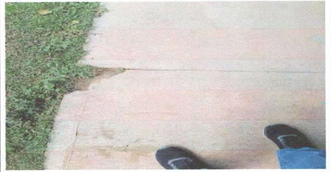
Foto 2. Modulo 1: Reparación piso de torta.
