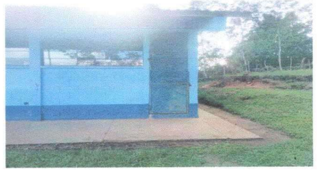
Foto 4. Modulo 1: Sustitución de puertas de metal
