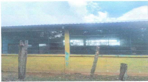
Foto 1. Modulo 1: suministro e instaciom de balcones
