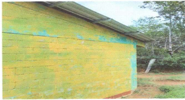
Foto 3. Modulo 1: Pintura en general. Pintura en muros exteriores e interiores.
