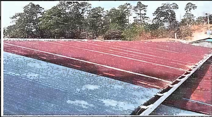
Foto1: MODULO 1: sustitución de Lamina Troquelada
