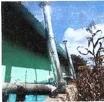
Foto 3 Módulo 1: Sustitución de chimenea de metal
