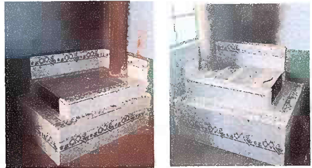
Foto 4 Módulo 1: Intalación de azulejo en estufa rural
