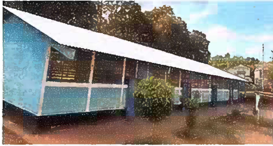
Foto1: modulo I, sustitucion de lamina por lamina aluzin calibre 26 y sustitucion de capote.
