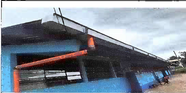
Foto 3: Modulo I, sustitucion de canales de pvc.
