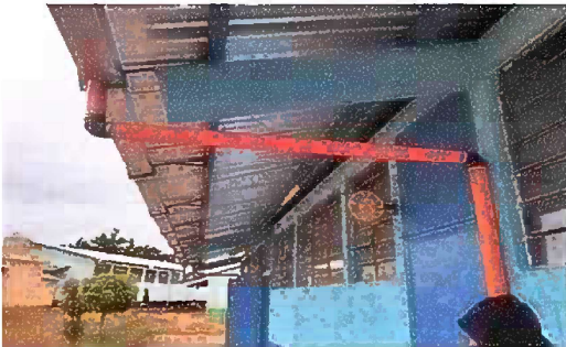
Foto 3: Modulo I, sustitucion de canales de pvc.
