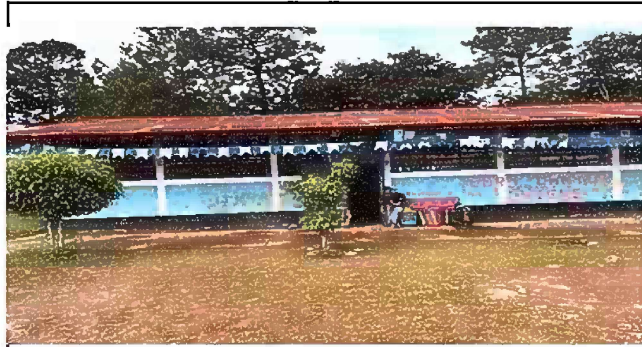
Foto1: modulo I, sustitucion de lamina por lamina aluzin calibre 26 y sustitucion de capote.
