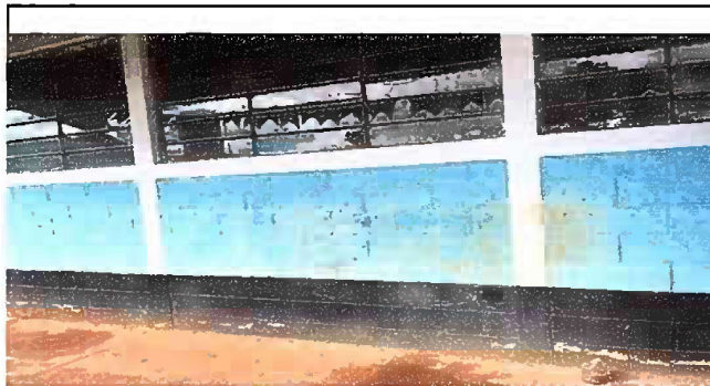
Foto 3: Modulo I, sustitucion de canales de pvc.
