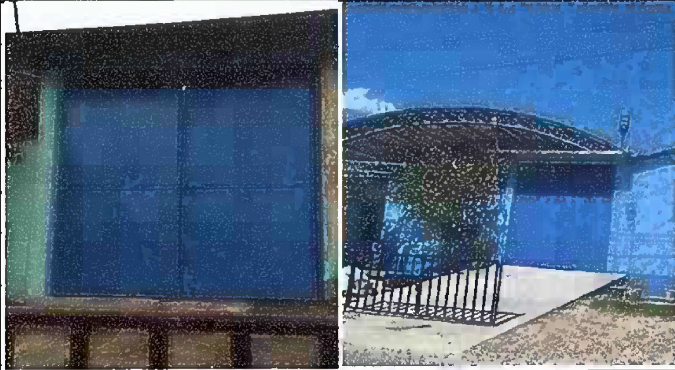
Foto 7: Muro Perimetral: Mantenimiento a portones de metal
