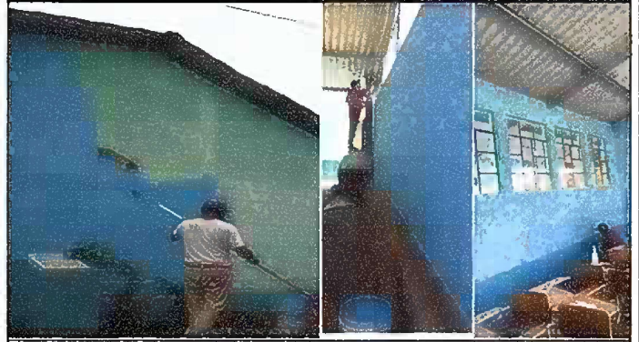
Foto 8: Pintura General: Pintura en muros exteriores e interiores
