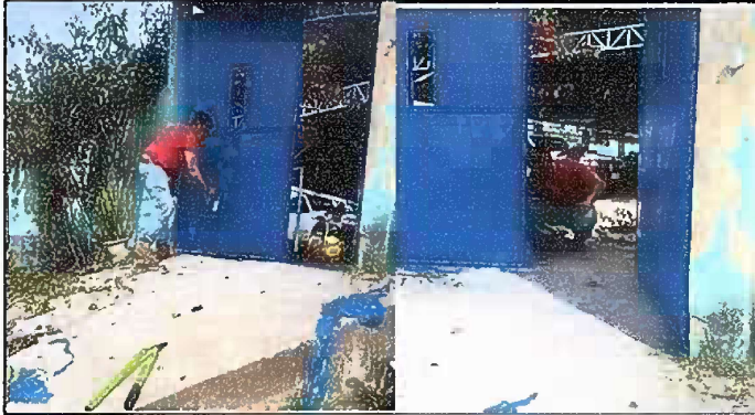
Foto 7: Muro Perimetral: Mantenimiento a portones de metal
