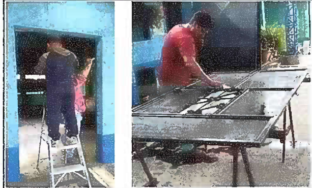
Foto 2: Modulo 1. Mantenimiento estructura de puertas
