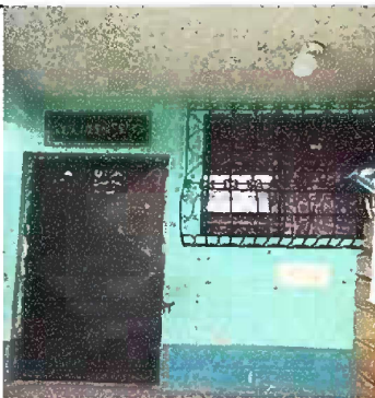
Foto 5: Modulo 2. Mantenimiento estructura de puertas
