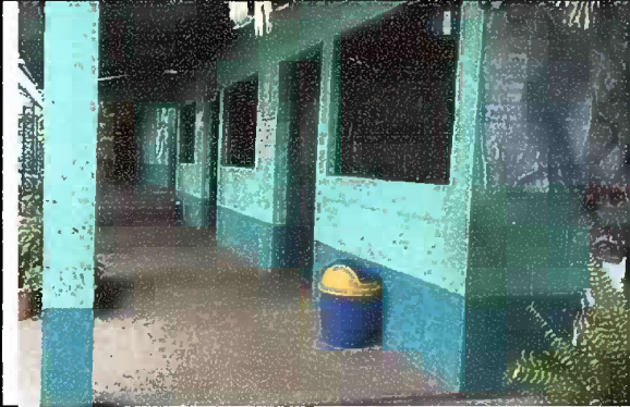
Foto 1: Modulo 1. Sustitución de piso de torta de concreto a piso de granito
