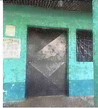
Foto 2: Modulo1. Mantenimiento estructura de puertas
