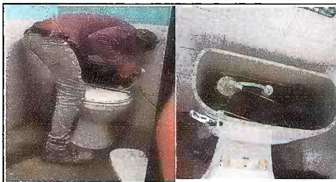
FOTO 5. MÓDULO 2: Sustitución de accesorios de inodoro (contra llave, tubo de abasto y tanque).
