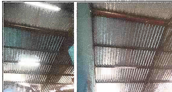
FOTO 22. MÓDULO 5: Sustitución de lámina por lámina troquelada aluzinc calibre 26.
