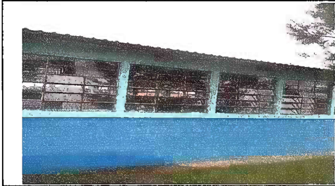
FOTO 1. MÓDULO 1: Sustitución de vidrios.
