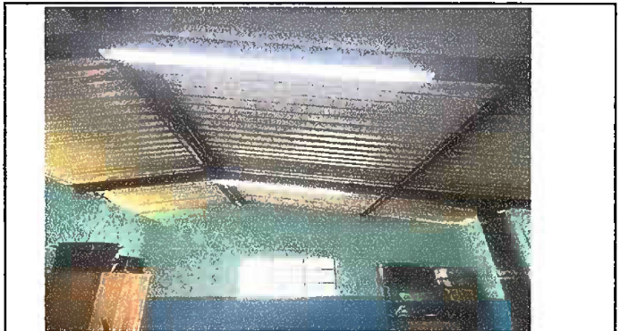
FOTO 4. MÓDULO 2: Sustitución de lámparas 2 x 40.
