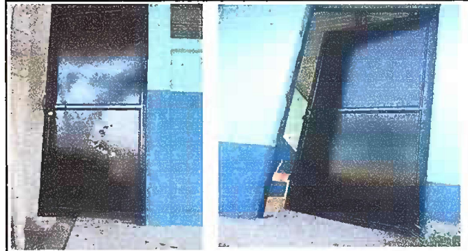
FOTO 20. MÓDULO 5: Mantenimiento a estructura de puerta (lijado, cambio de tubo, cepillado, sujeciones y aplicación de pintura). Reajuste de puerta.
