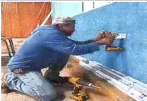
FOTO 17. MÓDULO 4: Sustitución de tomacorrientes doble.
