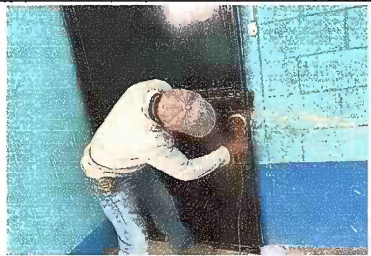
FOTO 8. MÓDULO 2: Mantenimiento a estructura de puerta (lijado, cambio de tubo, cepillado, sujeciones y aplicación de pintura). Reajuste de puerta.
