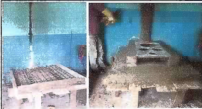
FOTO 9. MÓDULO 2: Sustitución de estufa rural (completo: incluye chimenea y plancha de metal).
