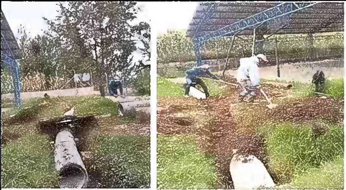
FOTO 26. AREA EXTERIOR. Cambio de cuneta por tubos de cemento.
