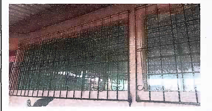
Foto 3: Modulo 1 Sustitución de balcón de metal.
