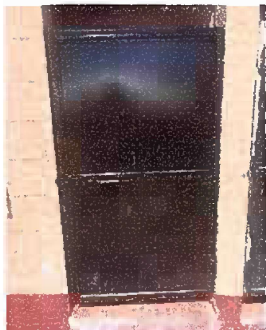
Foto 17: Modulo 5 Sustitución de puerta.
