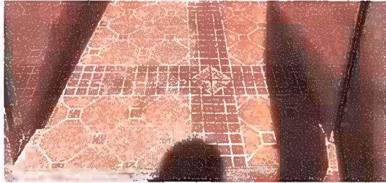
Foto13: Modulo 5 Sustitución de Piso cerámico
