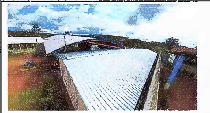
Foto 1: Módulo 1 Sustitución de lámina troquelada aluzinc calibre 26
