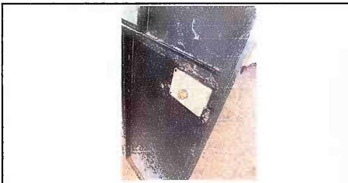
Foto 5: Módulo 1 Sustitución de Chapa
