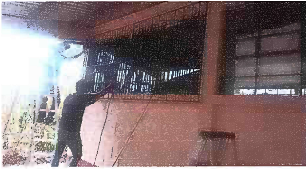
Foto 3: Modulo 1 Sustitución de balcón de metal.
