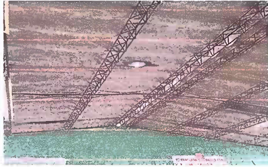
Foto 2: Modulo 1 Sustitución de capote de lámina para lámina troquelada, sustitución de elementos de fijación (tornillos).
