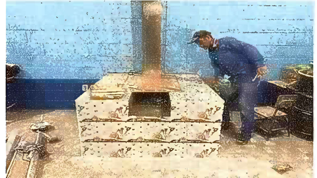
Foto2: MODULO 1. Sustitución de estufas rurales (completa) incluye chimenea y plancha de metal
