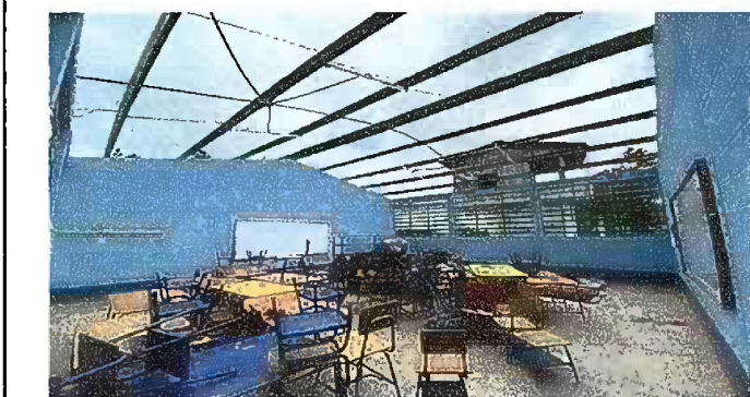
Foto 3: Modulo 2 Sustitución de lamina, por lamina troquelada aluzinc calibre 26
