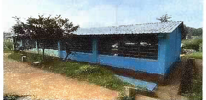
Foto 4: Pintura General, pintura en muros exteriores e interiores
