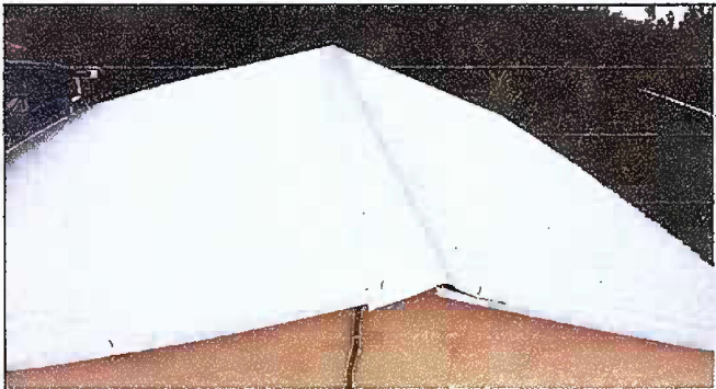
Foto1: Esta foto es del Módulo 1 de sustitución de techado de aula, CUBIERTA DE LAMINA, FASE FINAL
