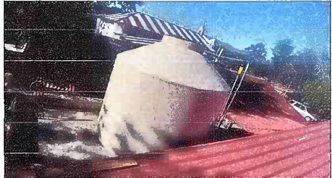
Foto 8: Esta foto es del Módulo 4 de sustitución de depósito de agua, REPARACIÓN Y MANTENIMIENTO DE CISTERNAS / DEPÓSITO DE AGUA. FASE FINAL
