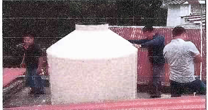
Foto 8: Esta foto es del Módulo 4 de sustitución de depósito de agua, REPARACIÓN Y MANTENIMIENTO DE CISTERNAS / DEPÓSITO DE AGUA. Fase de trabajo
