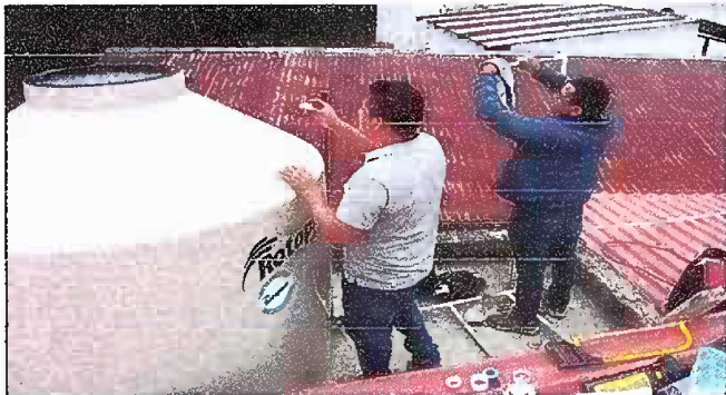
Foto 9: Esta foto es del Módulo 4 de sustitución de depósito de agua, REPARACIÓN Y MANTENIMIENTO DE CISTERNAS / DEPÓSITO DE AGUA. Fase de trabajo
