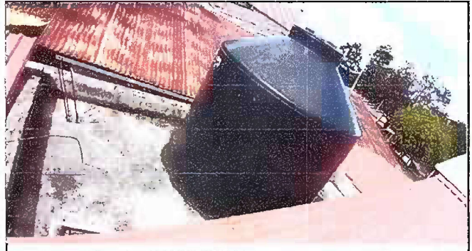
Foto 8: Esta foto es del Módulo 4 de sustitución de depósito de agua, REPARACIÓN Y MANTENIMIENTO DE CISTERNAS / DEPÓSITO DE AGUA.
