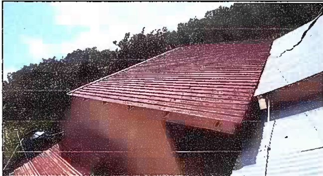
Foto7: Esta foto es del Módulo 3, de sustitución de lamina del aula, CUBIERTA DE LAMINA
