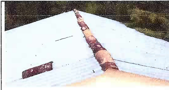
Foto1: Esta foto es del Módulo 1 de sustitución de techado de aula, CUBIERTA DE LAMINA
