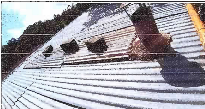
Foto 3: Esta foto es del Módulo 2 de sustitución de techado de la cocina, CUBIERTA DE LAMINA
