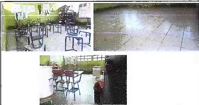
Foto 5: Modulo 8, Sustitución de torta de cemento por cerámica
