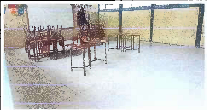
Foto 3: Modulo 5, Sustitución de torta de cemento por cerámica
