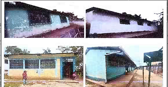
Foto 10: Pintura de pared interior y exterior.
