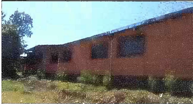
Foto1: Modulo 1. Colocacion de balcones y sustitucion de canales de pvc por metal y pintura en paredes exteriores.
