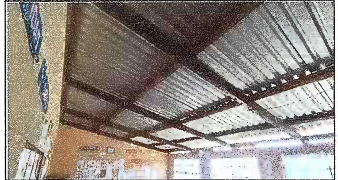
Foto 4: Modulo 2. Sustitucion de estructura de soporte de madera por metal.
