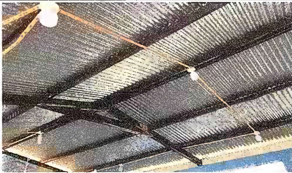
Foto 3. Módulo 2: Sustitución de focos ahorradores.
