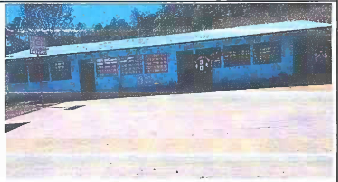
Foto 4 PATIO: Reparación de plancha de concreto patio
