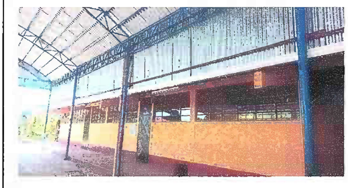
Modulo 1: Sustitucion de canales PVC, prescantes
