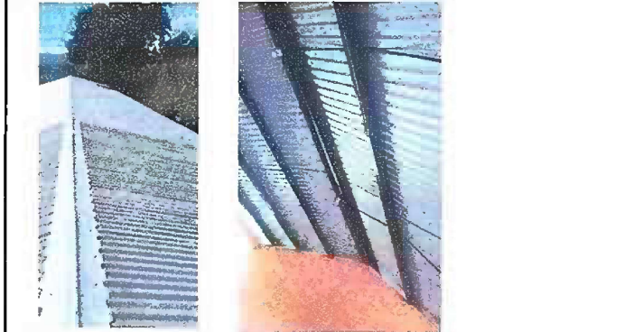
Modulo 1: sustitución de lámina por lámina troquelada, sustitución de capote, sustitución de canales, sustitución de pescante, sustitución de bajada de agua pluvial de PVC.
