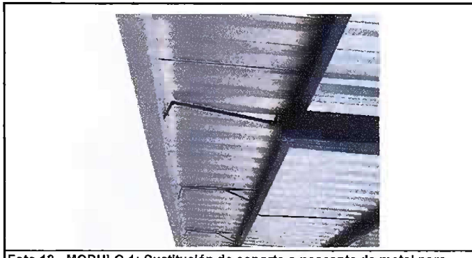
Foto 12 - MODULO 1: Sustrucción de soporte o pescante de metal para canal
