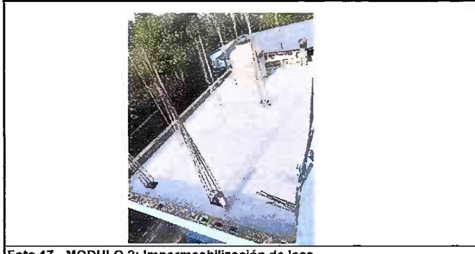
Foto 17 - MODULO 2: Impermeabilización de losa
