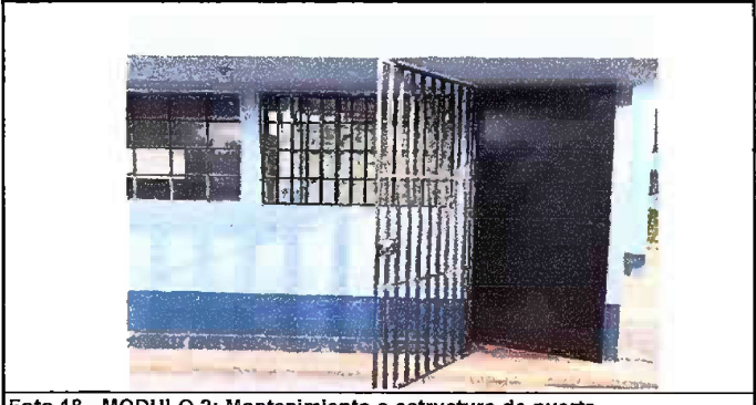
Foto 18 - MODULO 2: Mantenimiento a estructura de puerta
