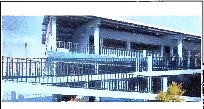
Foto 14 - MODULO 1: Mantenimiento a barandas de metal
