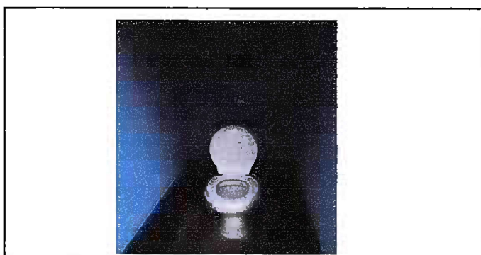
Foto 24 - MODULO 3: Sustitución inodoro
