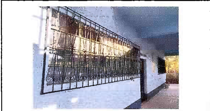
Foto 3 - MODULO 1: Mantenimiento a balcones de metal
