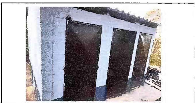
Foto 23 - MODULO 3: Mantenimiento a estructura de puerta
