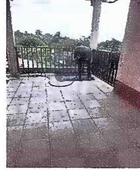
Foto 14 - MODULO 1: Mantenimiento a barandas de metal
