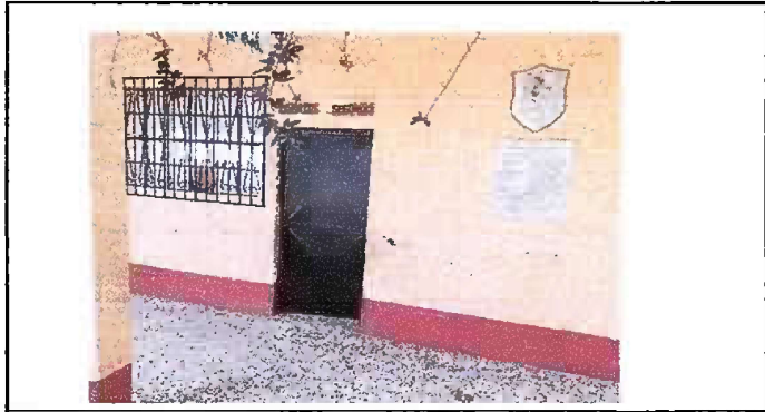
Foto 1 - MODULO 1: Mantenimiento a estructura de puerta
