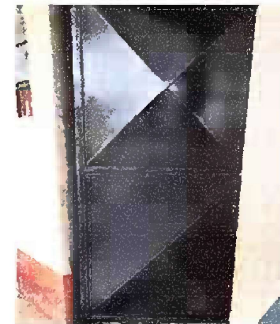
Foto 18 - MODULO 2: Mantenimiento a estructura de puerta
