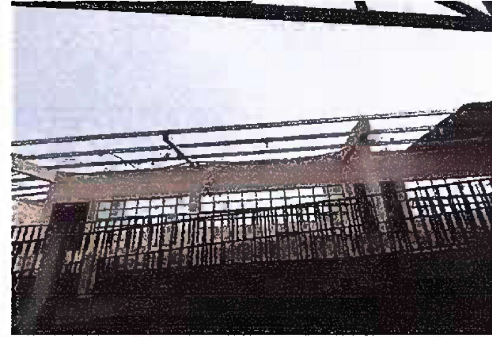
Foto 8 - MODULO 1: Sustitución de capote de lámina para lámina troquelada
