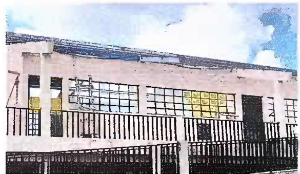
Foto 10 - MODULO 1: Mantenimiento a estructura de soporte de metal
