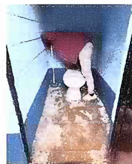
Foto 24 - MODULO 3: Sustitución inodoro
