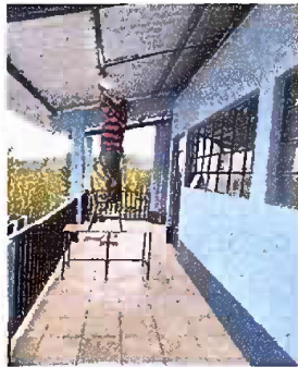
Foto 15 - MODULO 1: Sustitución de focos ahorradores
