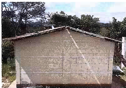
Foto 21 - MODULO 3: Sustitución de capote de lámina para lámina troquelada
