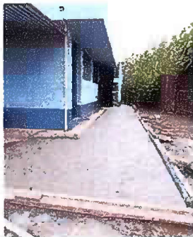
Foto 19 - MODULO 2: Reparación de banquetas de concreto
