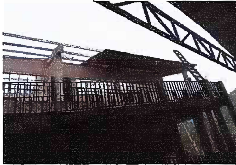
Foto 7 - MODULO 1: Sustitución de lámina, por lámina troquelada aluzinc calibre 26
