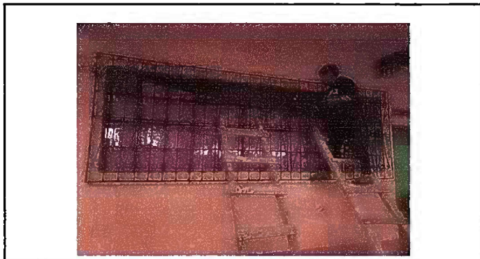
Foto 3 - MODULO 1: Mantenimiento a balcones de metal
