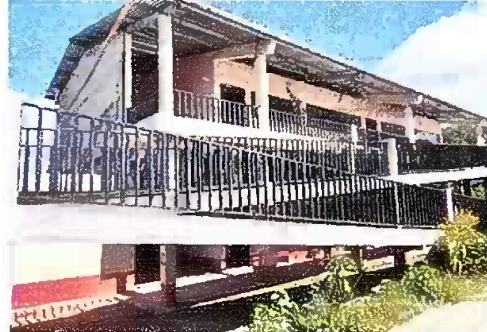
Foto 14 - MODULO 1: Mantenimiento a barandas de metal
