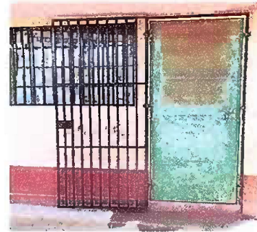
Foto 18 - MODULO 2: Mantenimiento a estructura de puerta
