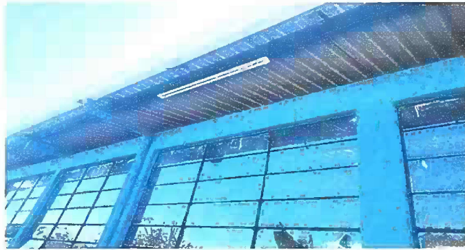
Foto 1: Modulo 1 Sustitución de lamparas tipo LED
