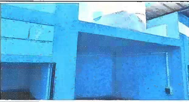
Foto 11: Modulo 2 Pintura en muros exteriores e interiores
