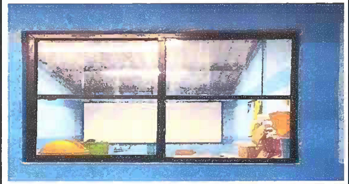
Foto 2: Modulo 3 Fabricacion e instalacion de ventana de metal.
