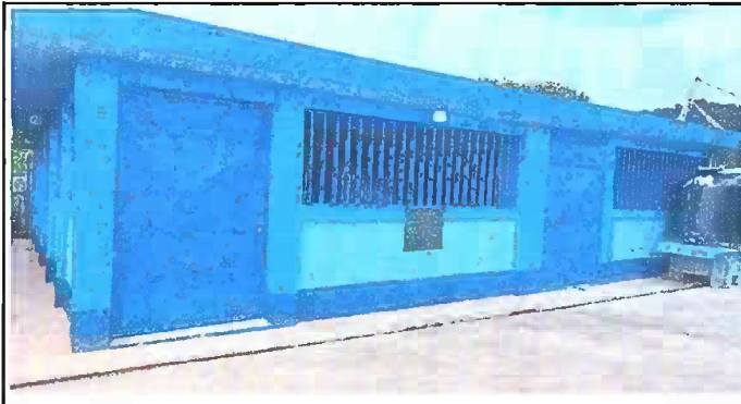
Foto19: MODULO 5 Pintura en muros exteriores e interiores
