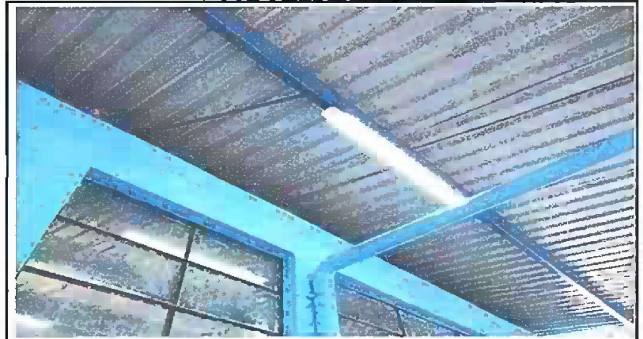
Foto 2: Modulo 1 Sustitución de lamparas tipo LED
