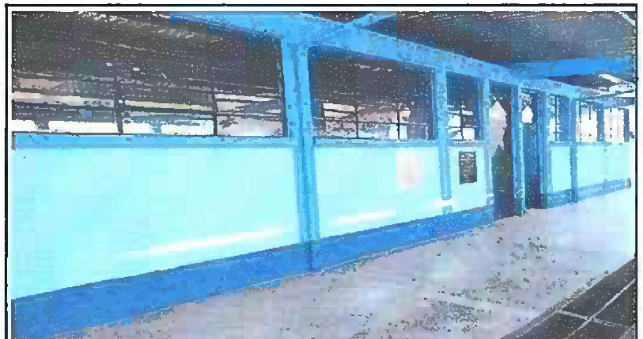
Foto 4: Modulo 1 Pintura en muros exteriores e interiores
