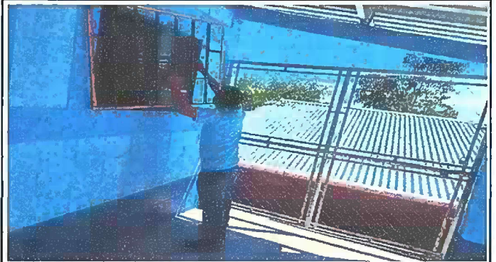
Foto 2: Modulo 3 Fabricación e instalacion de ventana de metal.
