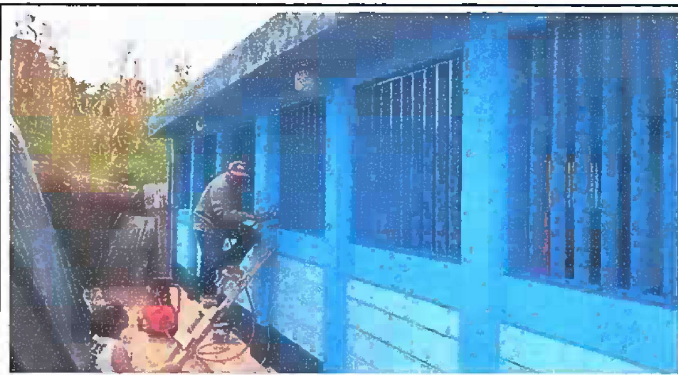
Foto 3: Modulo 5 Mantenimiento a barandas de metal.
