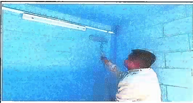
Foto 11: Modulo 2 Pintura en muros exteriores e interiores
