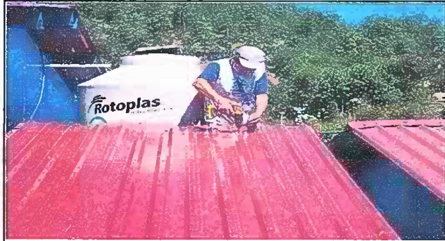
Foto 7: Modulo 2 Sustitución de lámina por lámina troquelada aluzinc calibre 26, Instalación de lámina troquelada aluzinc, Sustitución de elementos de fijacion (tornillos).
