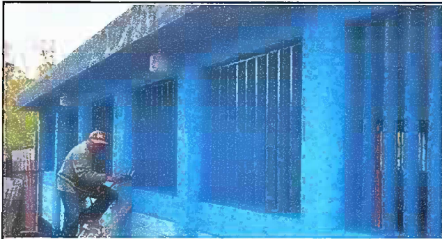
Foto19: MODULO 5 Pintura en muros exteriores e interiores
