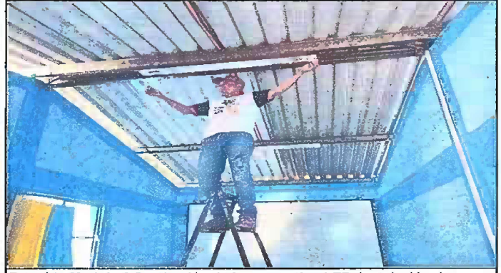
Foto 14: Modulo 3 Sustitución de lamparas tipo LED, Instalación de unidades luz (incluye interruptor, ducto y cable eléctrico)
