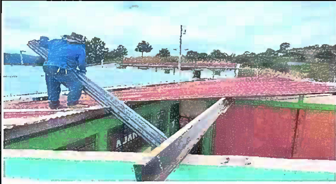
Foto 1: Modulo 1 Sustitución de lámina por lámina troquelada aluzinc calibre 26, Instalación de lámina troquelada aluzinc, Sustitución de elementos de fijación (tornillos).
