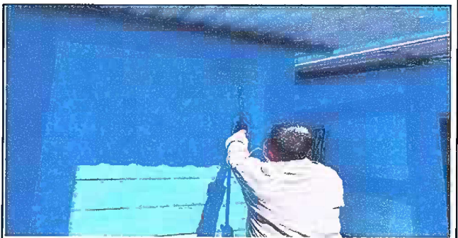
Foto 12: Modulo 3 Pintura en muros exteriores e interiores
