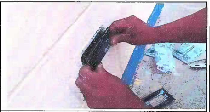
Foto 6: Modulo 1 Sustitución de tomacorrientes dobles
