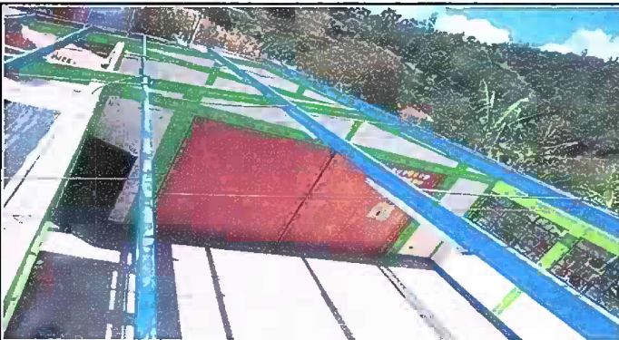
Foto 3: Modulo 1 Mantenimiento a estructura de soporte de metal
