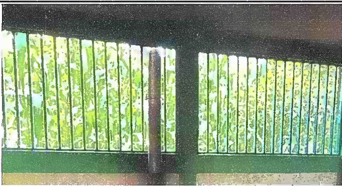
Foto 3: Modulo 5 Mantenimiento a barandas de metal.
