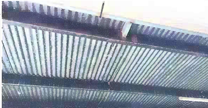
Foto 3: Modulo 1 Mantenimiento a estructura de soporte de metal
