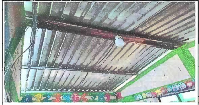
Foto 14: Modulo 3 Sustrituónde lamparas tipo LED, Instalación de unidades luz (incluye interruptor, ducto y cable eléctrico)
