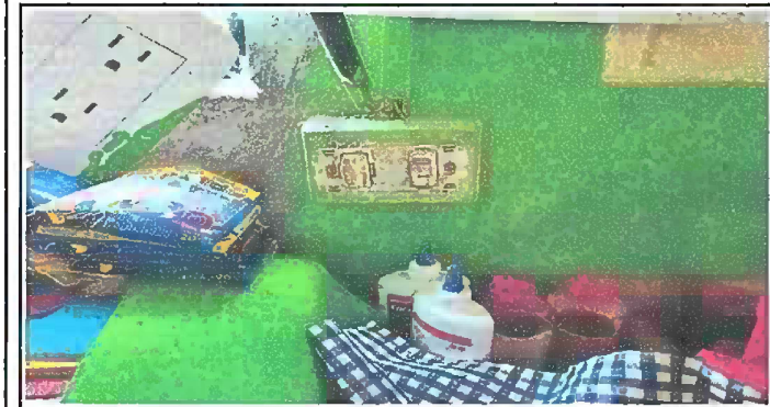
Foto 15: Modulo 3 Sustrituónde interruptores dobles
