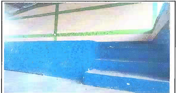
Foto 16: Modulo 4 Pintura en muros exteriores e interiores.
