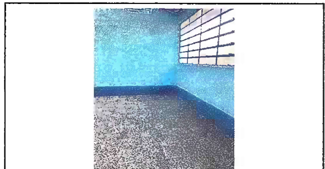
Foto No. 4 Módulo 3 sustitución de piso de cemento por piso de granito
