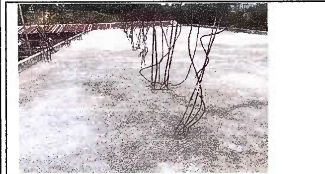
Foto 9 Módulo 2: Impermeabilización de losa
