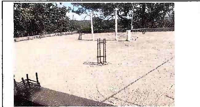
Foto 15 Módulo 3: Impermeabilización de loza
