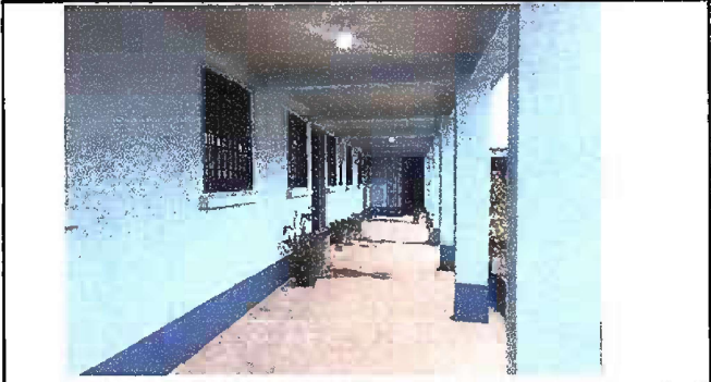
Foto 8 Módulo 2: Sustitución de focos ahorradores
