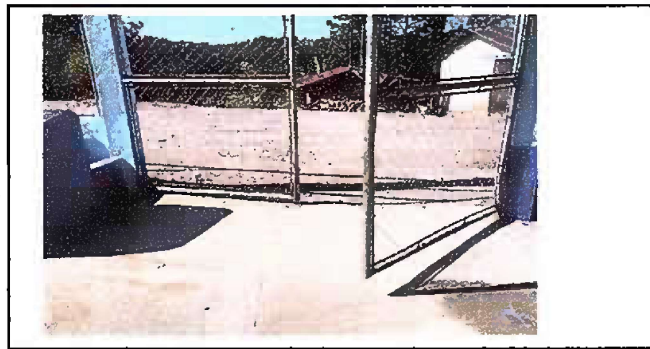
Foto 17 Muros perimetrales: Reparación de tubo hg malla galvanizada
