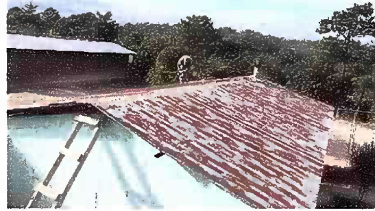
Foto 2 Módulo 1: Sustitución de elementos de fijación (tornillos)
