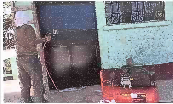
Foto 4 Módulo 1: Mantenimiento a estructura de puerta (lijado, aplicación de pintura)
