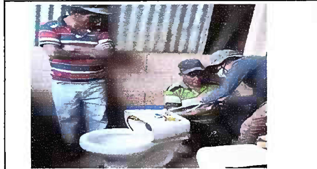
Foto 13 Módulo 3: Sustitución de accesorios inodoro (contra llave, tubo de abasto y tanque)
