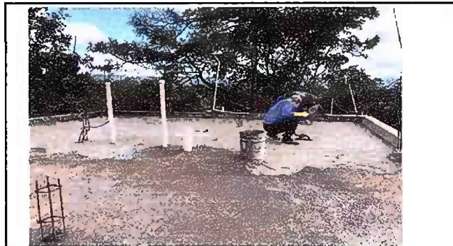
Foto 9 Módulo 2: Impermeabilización de losa
