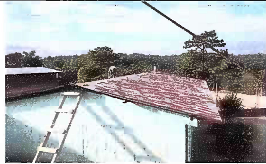
Foto 6 Módulo 1: Sustitución de capote de lámina para lamina troquelada
