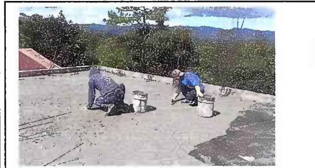
Foto 15 Módulo 3: Impermeabilización de loza
