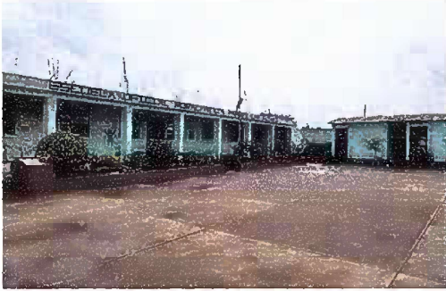
Foto 19 Pintura general: Pintura de muros interiores y exteriores
