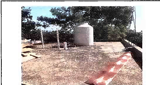
Foto 15 Módulo 3: Impermeabilización de loza
