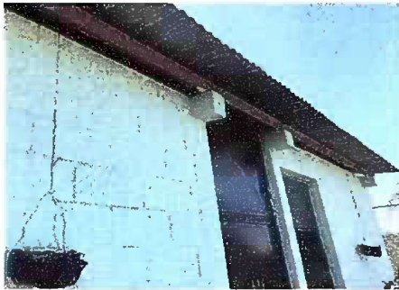
Foto 3 Módulo 1: Mantenimiento a estructura de soporte de metal
