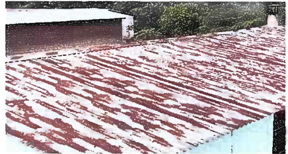
Foto 6 Módulo 1: Sustitución de capote de lámina para lamina troquelada
