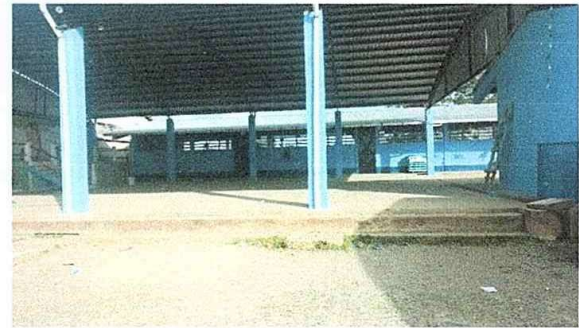
Foto 10: pintado de exteriores e interiores
