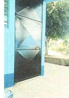
Foto 8: Modulo 8. Mantenimiento de puertas
