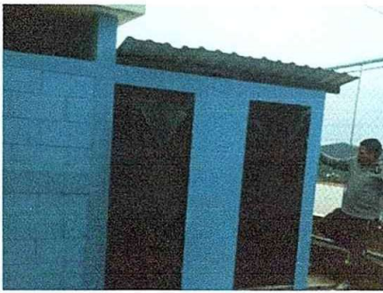
Foto 9: Modulo 10. Mantenimiento de puertas
