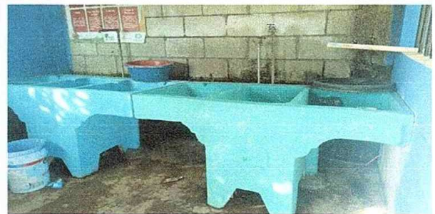
Foto 12: Area Exterior Sustitución de pilas
