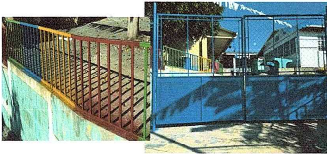
Foto 11: Area exterior mantenimiento de barandas y portones
