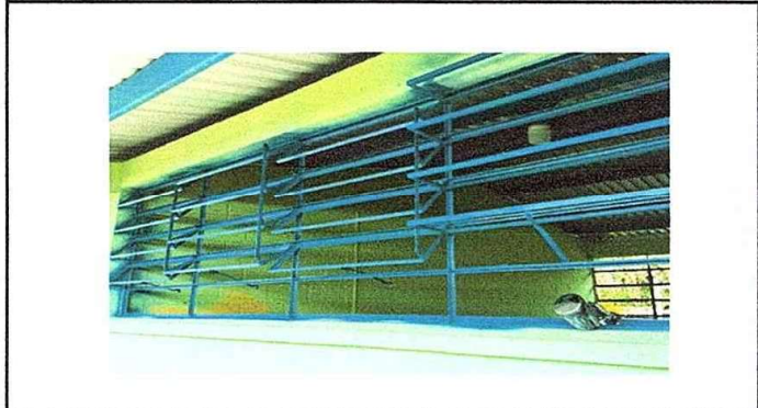
Foto 1: Modulo 1 Mantenimiento de estructura metal, sustitución de vidrios
