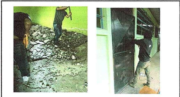
Foto 4: Módulo 3 sustitución piso de concreto, Mantenimiento de puertas
