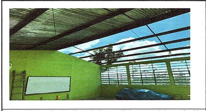
Foto 5: Módulo 4 Sustitución de lamina por lámina troquelada, sustitución de lemeños de fijación
