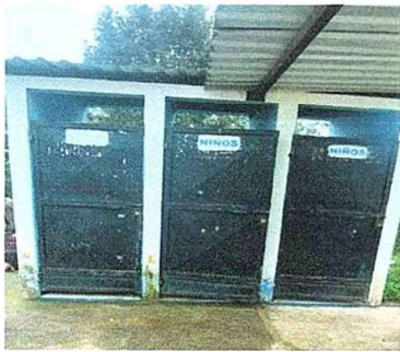
Foto 9: Modulo 10. Mantenimiento de puertas
