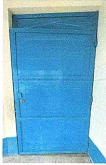
Foto 7: Modulo 5 Mantenimiento de puertas
