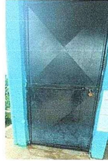
Foto 8: Modulo 8. Mantenimiento de puertas
