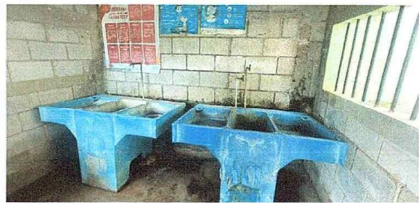
Foto 12: Area Exterior Sustitución de pilas
