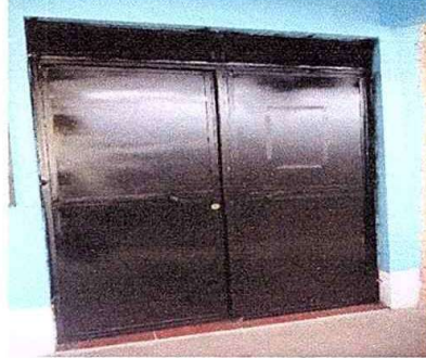
Foto 8: Módulo 2. Mantenimiento a estructura de puerta (lijado y pintura).
