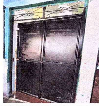
Foto 4: Módulo 1. Mantenimiento a estructura de puerta (lijado y pintura).
