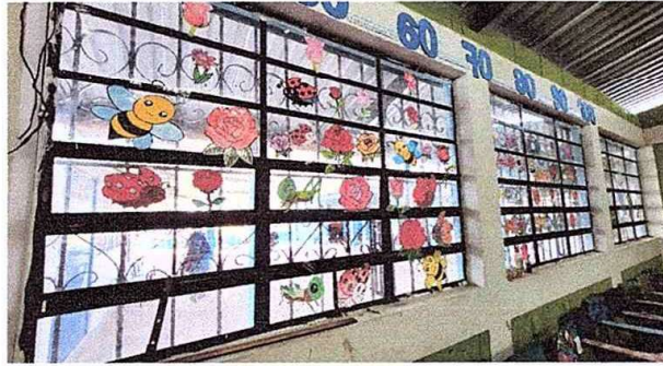
Foto 7: Módulo 2. Sustitución de vidrios.
