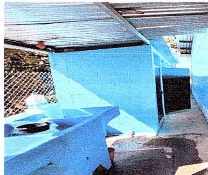
Foto 14: Módulo 3. Mantenimiento a estructura de puerta (lijado y pintura).
