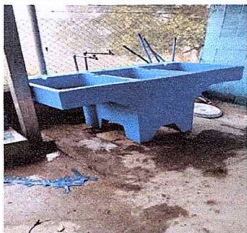
Foto 13: Módulo 3. Sustrucción de pila para lavar.
