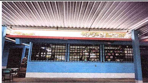
Foto 9: Módulo 2. Reparación de bajada de agua pluvial.
