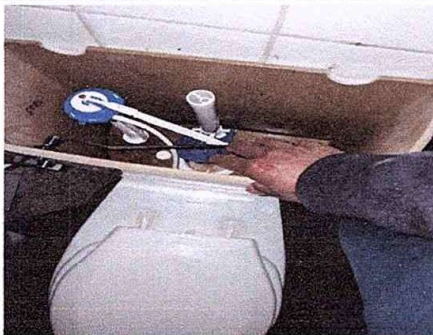
Foto 11: Módulo 3. Sustitución accesorios de inodoros.
