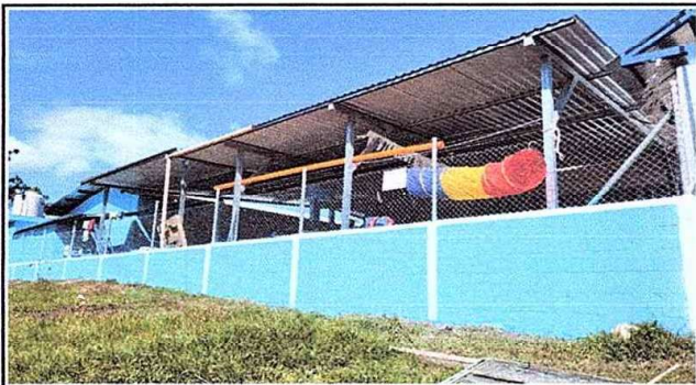
Foto 15: Pintura General. Pintura de muros interiores y exteriores.
