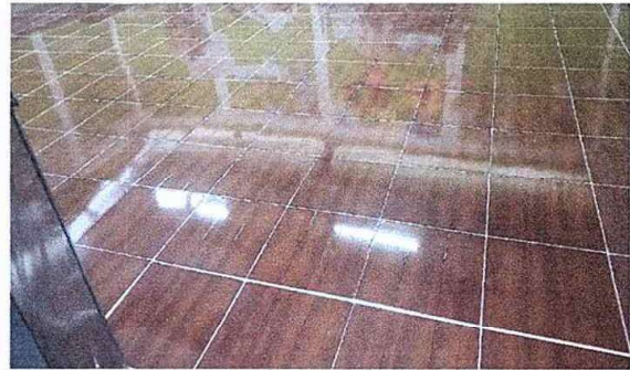
Foto 10: Módulo 2. Sustitución de torta de cemento a piso cerámico.
