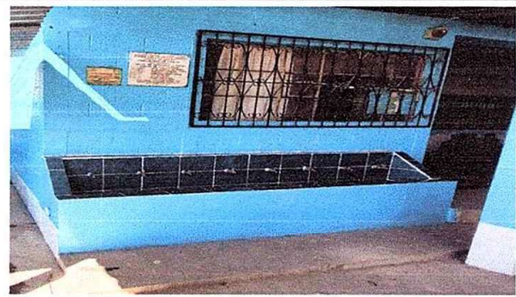
Foto 12: Módulo 3. Sustitución de azulejos en lavamanos.
