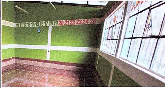
Foto1: Módulo 1. Sustitución de vidrios.
