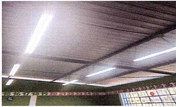
Foto 3: Módulo 1. Sustitución de lámparas led.
