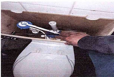
Foto 11: Módulo 3. Sustitución accesorios de inodoros.
