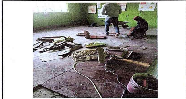
Foto 2: Módulo 1. Sustitución de torta de cemento a piso cerámico.
