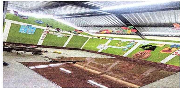
Foto 10: Módulo 2. Sustitución de torta de cemento a piso cerámico.
