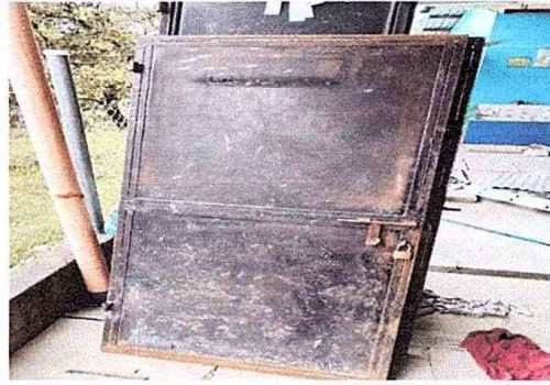
Foto 14: Módulo 3. Mantenimiento a estructura de puerta (lijado y pintura).
