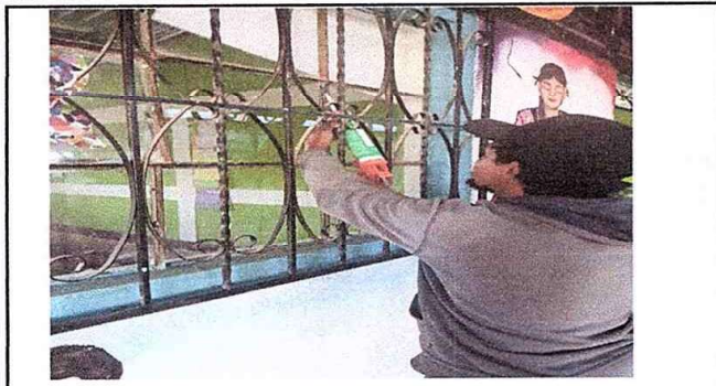
Foto1: Módulo 1. Sustitución de vidrios.
