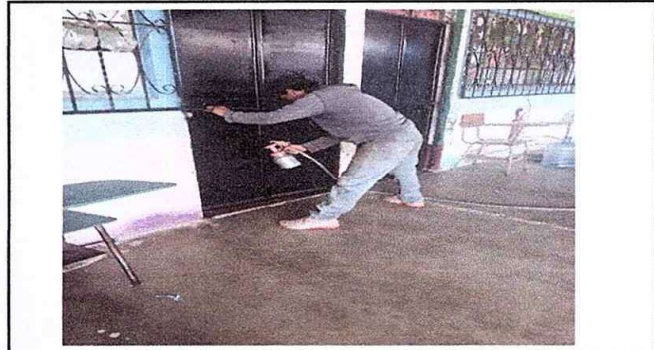
Foto 4: Módulo 1. Mantenimiento a estructura de puerta (lijado y pintura).
