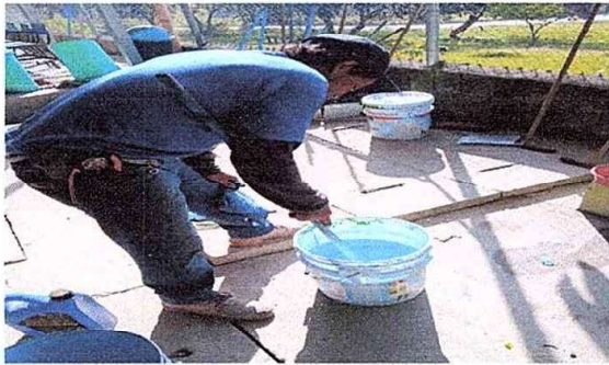
Foto 15: Pintura General. Pintura de muros interiores y exteriores.
