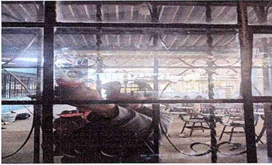
Foto 7: Módulo 2. Sustitución de vidrios.
