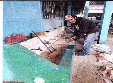
Foto 12: Módulo 3. Sustitución de azulejos en lavamanos.
