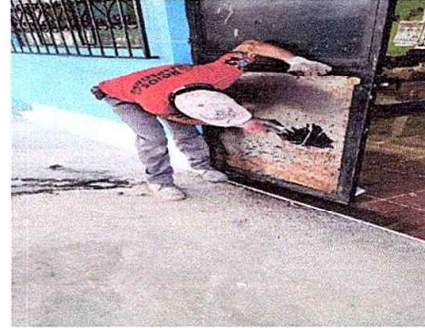
Foto 8: Módulo 2. Mantenimiento a estructura de puerta (lijado y tintura).
