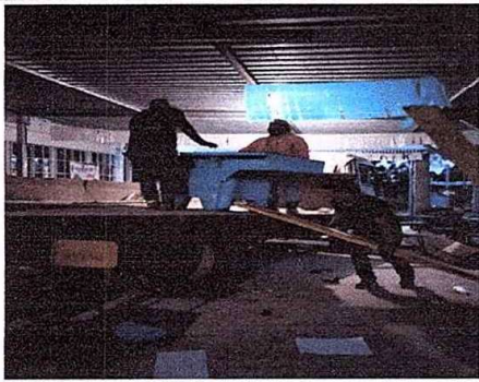
Foto 13: Módulo 3. Sustitución de pila para lavar.
