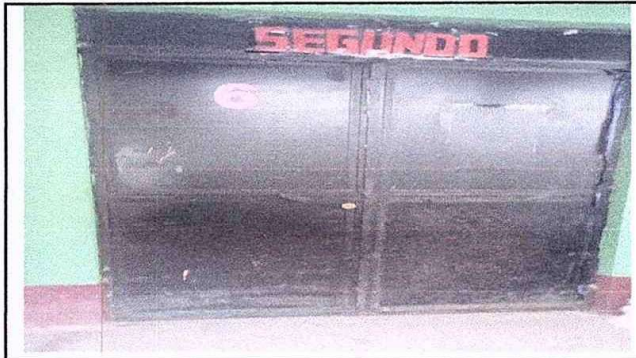
Foto 8: Módulo 2. Mantenimiento a estructura de puerta (lijado y tintura).
