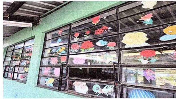
Foto 7: Módulo 2. Sustitución de vidrios.
