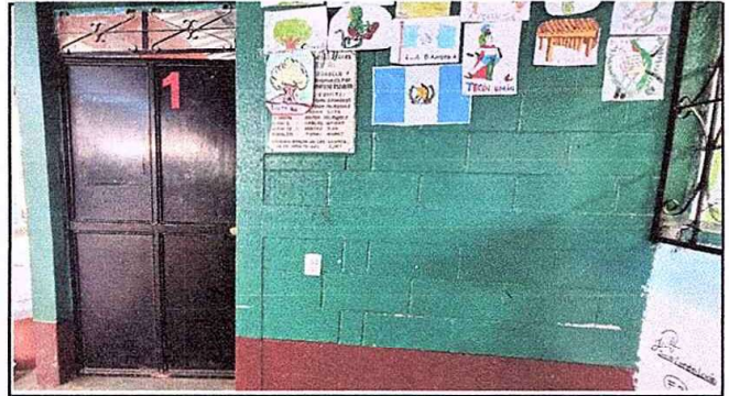
Foto 4: Módulo 1. Mantenimiento a estructura de puerta (lijado y pintura).
