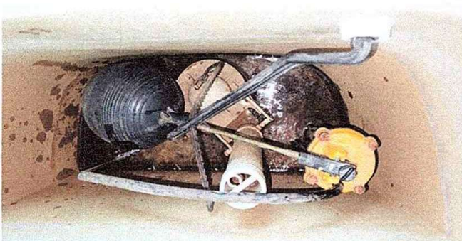
Foto 11: Módulo 3. Sustitución accesorios de inodoros.
