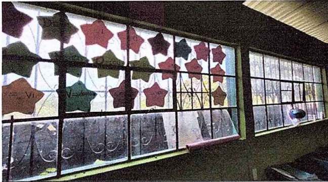
Foto 1: Módulo 1. Sustitución de vidrios.
