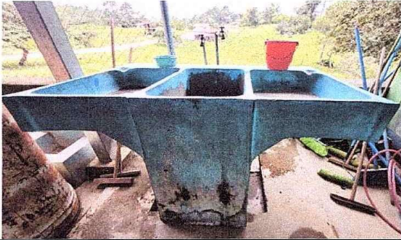
Foto 13: Módulo 3. Sustitución de pila para lavar.
