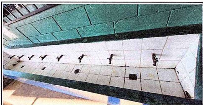
Foto 12: Módulo 3. Sustitución de azulejos en lavamanos.
