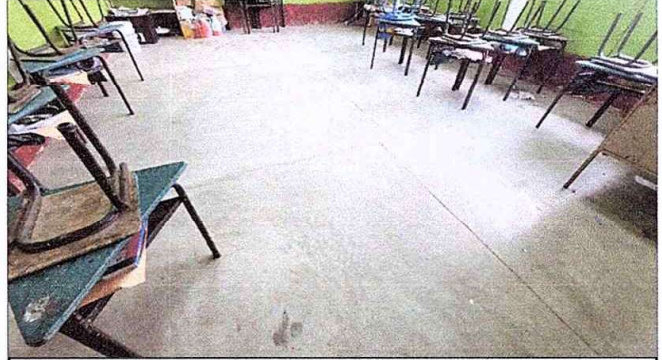
Foto 2: Módulo 1. Sustitución de torta de cemento a piso cerámico.
