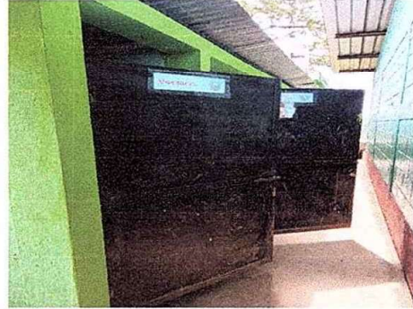
Foto 14: Módulo 3. Mantenimiento a estructura de puerta (lijado y pintura).
