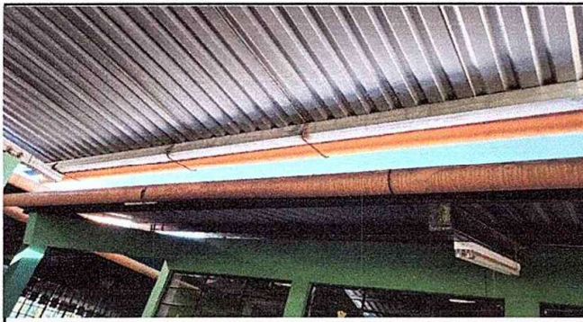
Foto 9: Módulo 2. Reparación de bajada de agua pluvial.
