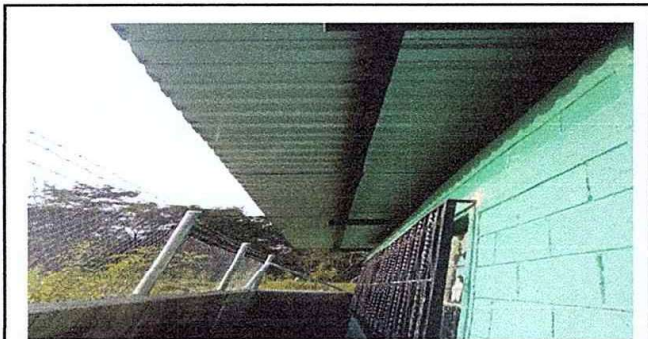
Foto 5: Módulo 1. Reparación de bajada de agua pluvial, tubo pvc.
