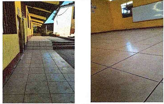
Foto 15: MODULO 3 Sustitucion de piso de torta de concreto por piso cerámico
