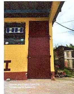
Foto 12: MODULO 2: Mantenimiento a estructura de puerta (lijado, cambio de tubo, cepillado, sujeciones, aplicacion de pintura)
