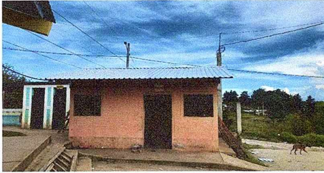
Foto 7: MODULO 1: Sustrucción de lámina por lámina troquelada aluzinc calibre 26
