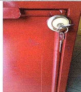
Foto 17: MODULO 3:Sustitución de chapa
