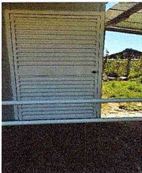
Foto 18: MODULO 4:Mantenimiento a estructura de puerta (lijado, cambio de tubo, cepillado, aplicación de pintura)
