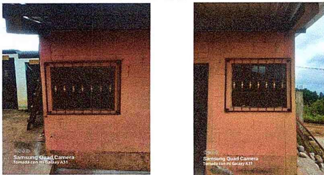
Foto 9: MODULO 1: Suministro e insalacion de balcones de metal de 0.90 x 1.12
