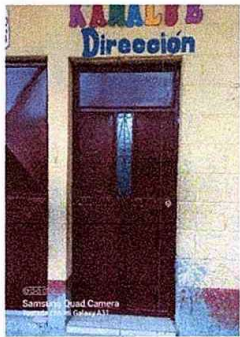
Foto 16: MODULO 3: Mantenimiento a estructura de puerta (lijado, cambio de tubo, cepillado, aplicación de pintura)
