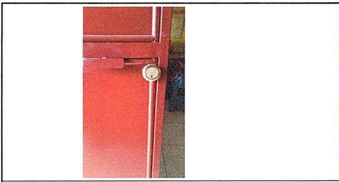
Foto 5: MODULO 1: Sustitución de chapa
