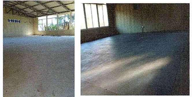
Foto 19: MODULO 4 :Sustitución de plataforma y piso de modulos prefabricados.
