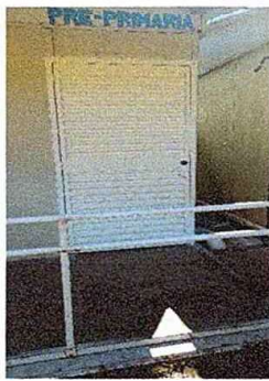
Foto 18: MODULO 4:Mantenimiento a estructura de puerta (lijado, cambio de tubo, cepillado, aplicación de pintura)
