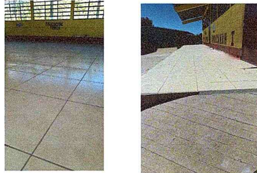
Foto 10: MODULO 2: Sustrucion de piso de torta de concreto por piso cerámico
