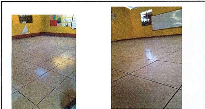
Foto 15: MODULO 3 Sustitucion de piso de torta de concreto por piso cerámico
