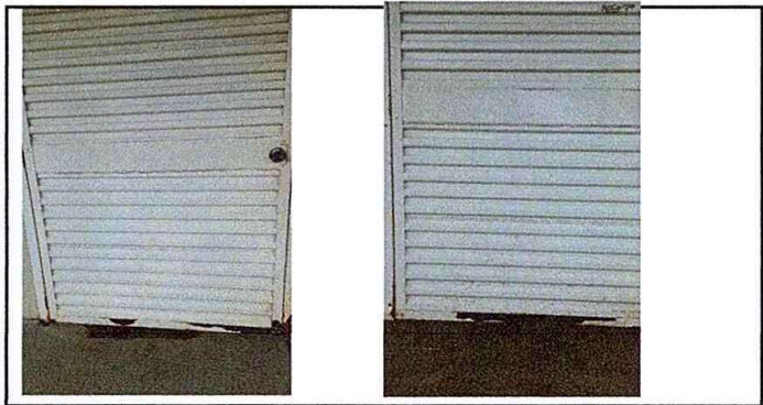
Foto 18: MODULO 4:Mantenimiento a estructura de puerta (lijado, cambio de tubo, cepillado, aplicación de pintura)
