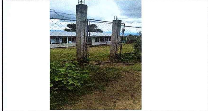
Foto 2: MURO PERIMETRAL Sustitución de puerta de metal 1.00 X 1.90 mts
