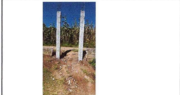
Foto 4: MURO PERIMETRAL: Reparación de columna de puerta de metal
