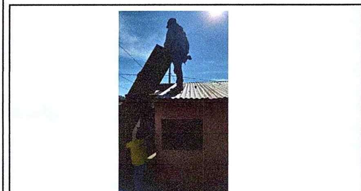
Foto 9: MODULO 1: Instalacion de lámina troquelada aluzinc calibre 26
