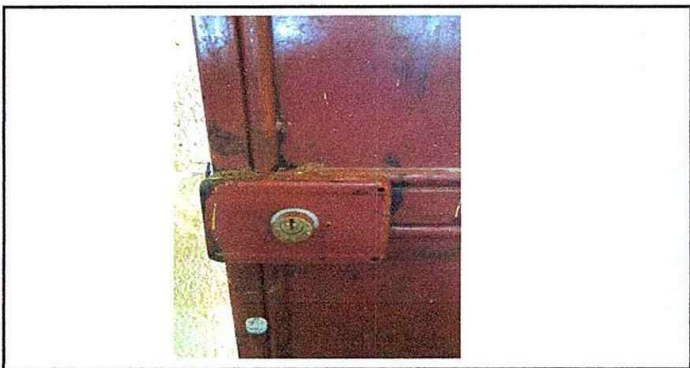
Foto 17: MODULO 3:Sustitución de chapa
