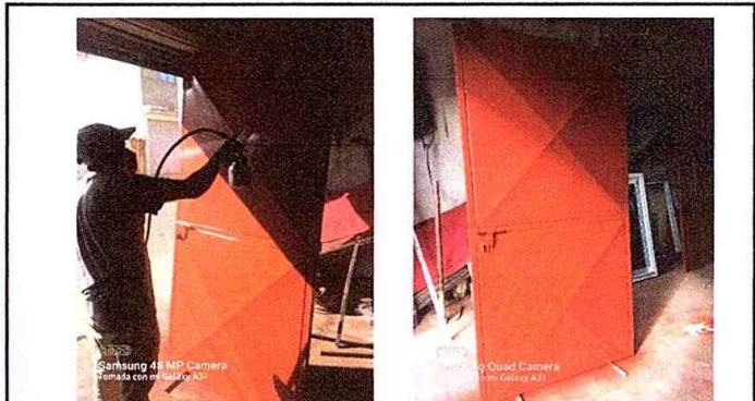
Foto 16: MODULO 3: Mantenimiento a estructura de puerta (lijado, cambio de tubo, cepillado, aplicación de pintura)
