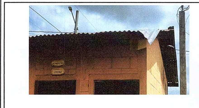
Foto 9: MODULO 1: Instalacion de lámina troquelada aluzinc calibre 26
