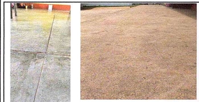
Foto 11: MODULO 2:Sustitucion de piso de torta de concreto por piso cerámico
