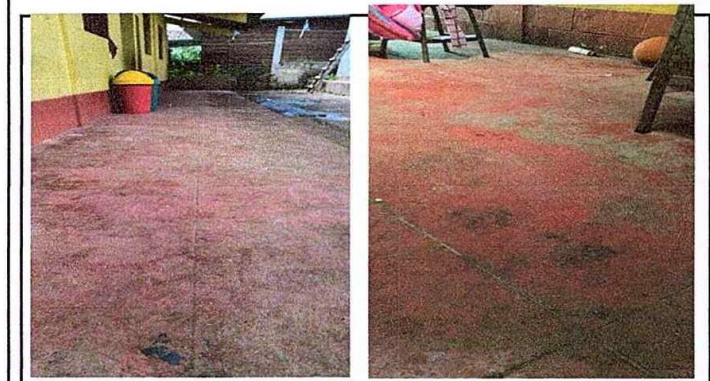
Foto 15: MODULO 3 Sustitucion de piso de torta de concreto por piso cerámico
