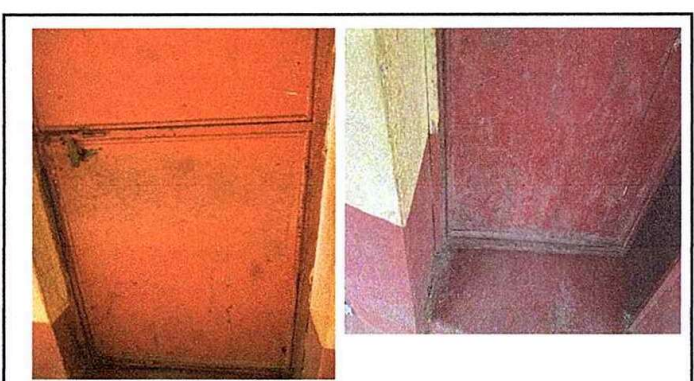
Foto 16: MODULO 3: Mantenimiento a estructura de puerta (lijado, cambio de tubo, cepillado, aplicación de pintura)
