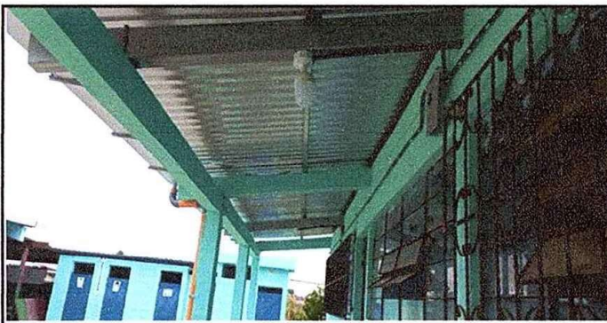
Foto 5: SISTEMA ELÉCTRICO. Reparación de sistema de energía eléctrica.
