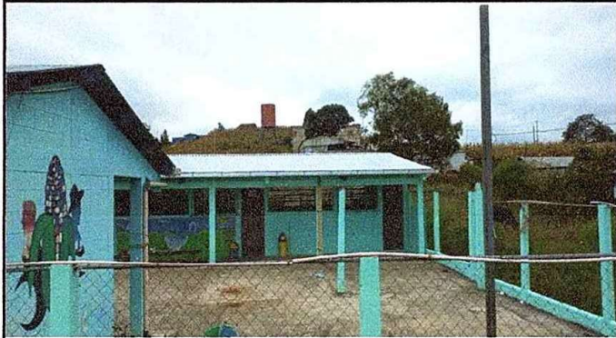
Foto 1: MODULO 1. Sustitución de lámina por lámina troquelada. Sustitución de canal.
