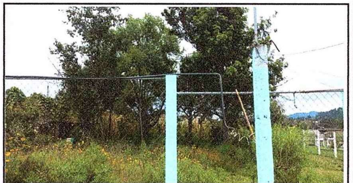
Foto 6: SISTEMA ELÉCTRICO. Reparación de acometida eléctrica.
