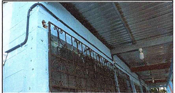
Foto 4: SISTEMA ELÉCTRICO. Reparación de sistema de energía eléctrica.
