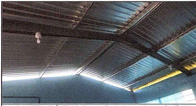
Foto 5: SISTEMA ELÉCTRICO. Reparación de sistema de energía eléctrica.
