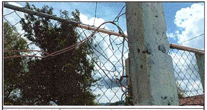
Foto 6: SISTEMA ELÉCTRICO. Reparación de acometida eléctrica.
