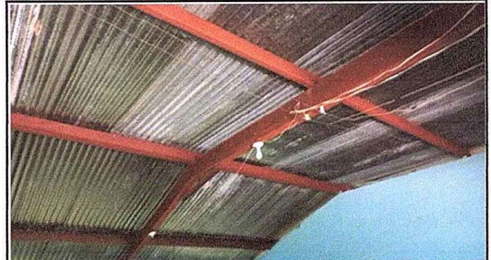
Foto 2: MODULO 1. Sustitución de estructura portante de metal por metal.
