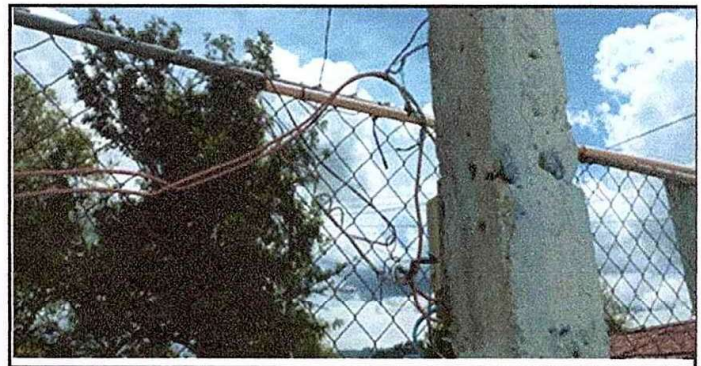
Foto 6: SISTEMA ELÉCTRICO. Reparación de acometida eléctrica.
