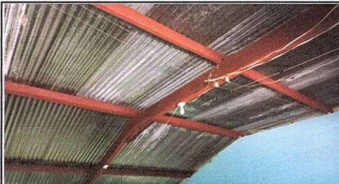
Foto 3: SISTEMA ELÉCTRICO. Reparación de sistema de energía eléctrica.
